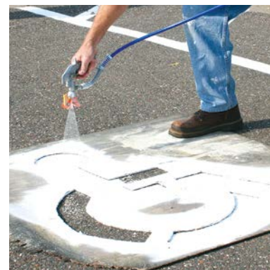
Нанесение разметки с помощью трафарета
