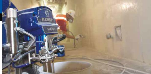
Наносите ли Вы краску или текстурные покрытия, компания Graco четко понимает Ваши требования - высокая скорость подачи материала и максимальная производительность. Вне зависимости от масштаба поставленной задачи распылители Mark серии ProContractor всегда позволяют обеспечить необходимую производительность!
